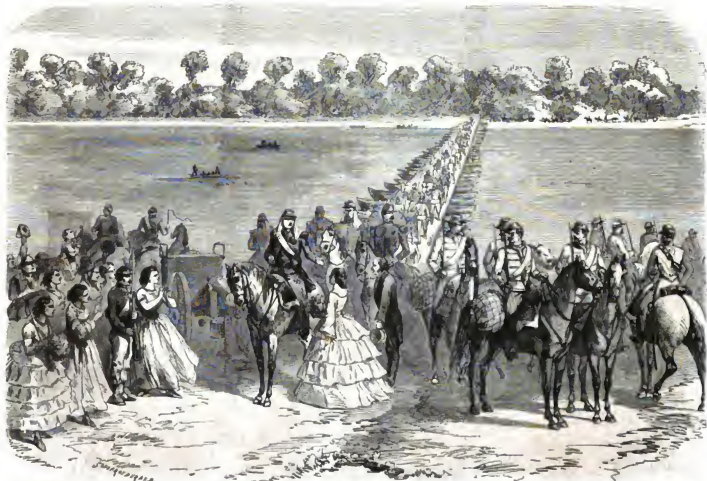
ARRIVÉE DU PRINCE NAPOLEÓN AU DÉBOUCHÉ DU PONT JETÉ SUR LE PO, DEVANT CASAL-MAGGIORE, PAR LA 7 e COMPAGNIE DU 6 e RÉGIMENT D'ARTILLIERS PONTONNIERS, POUR LE PASSAGE DU 2 e CORPS. (1 er JUILLET 1858)
